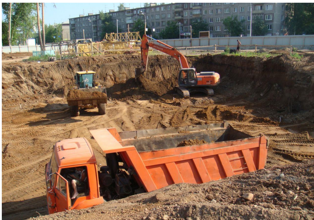
12 Сурет – Котлован қазу процесі
